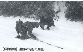
【群偵察班】道路の勾配の測量
