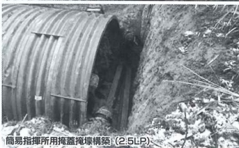
簡易指揮所用掩壕掩壕構築(2.5LP)
